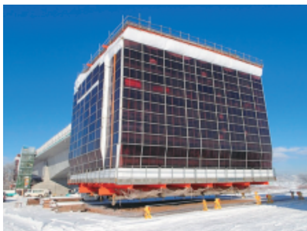
写真1 冬期施工における仮設上屋設置状況
