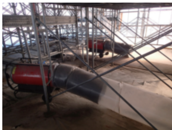
写真2 仮設上屋内のヒーター稼働状況
