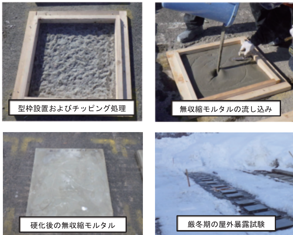
写真4 耐寒無収縮モルタルの屋外暴露試験
