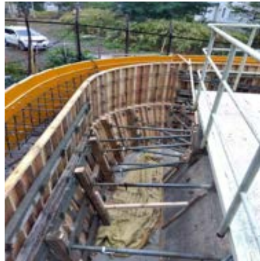
■ 型枠施工状況の一例
