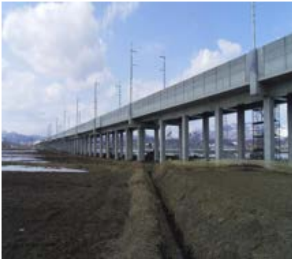
■ 函館新幹線工事の写真
