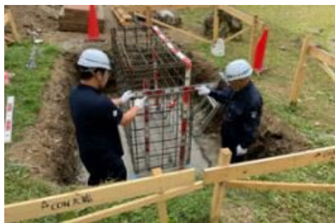
▲非常用発電機設置工事
