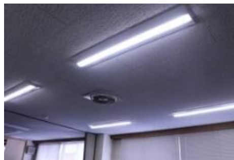
▲事務所 LED 化工事
