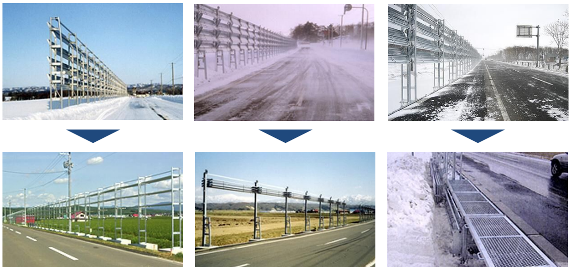
▲ 路面への雪の堆積を防ぐための防雪柵。収納方法や形状の違いなどにより様々な種類が存在する。
