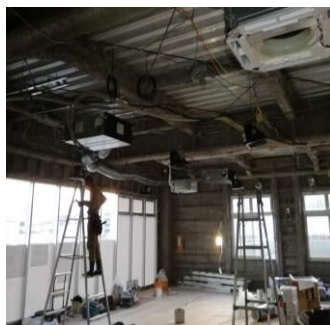
■空調工事の様子
