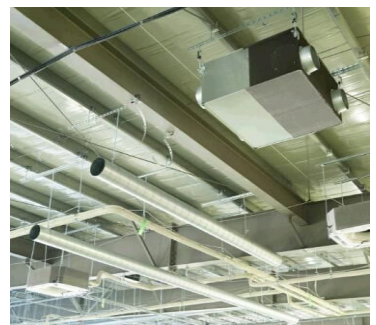
■ダクト工事施行例
