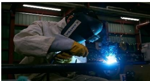
■ 配管加工の様子
