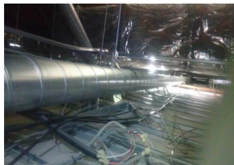
■換気工事の現場
