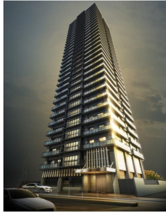
▲ファインシティ札幌ザ・タワー大通公園
