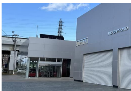
▲設置した太陽光パネル
