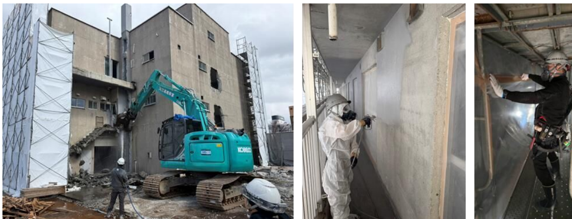
▲ 小学校や公営住宅、介護施設などの幅広い建築物の解体・アスベスト除去工事実績多数
