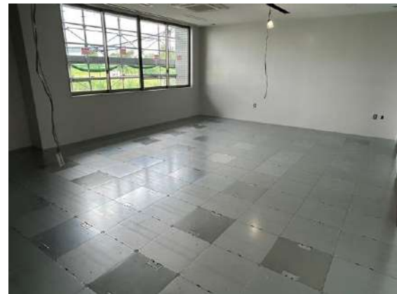
▲ OAフロア工事
