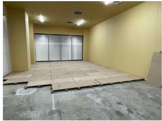
▲ 乾式二重床工事
