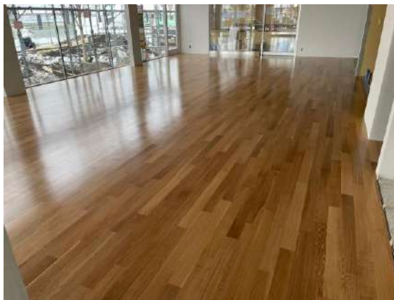
▲ フローリング工事
