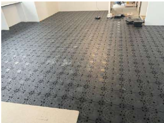
▲ OAフロア工事
