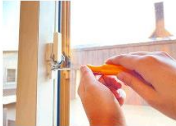
サッシの開閉調整
