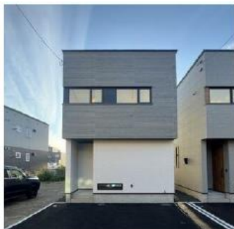
《建売住宅の施工例》
