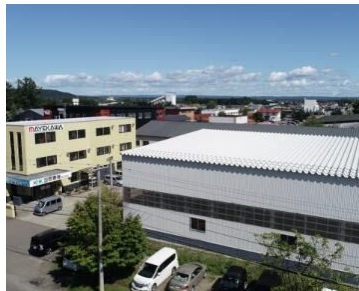
▲タチノウェストビル & 貸倉庫
