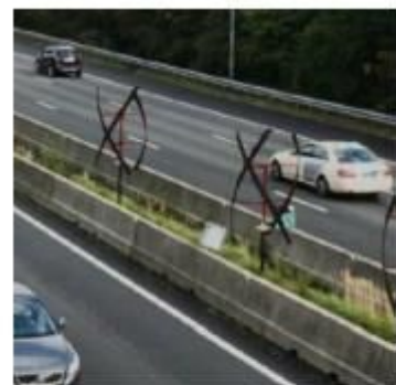
【参考】高速道路での設置
