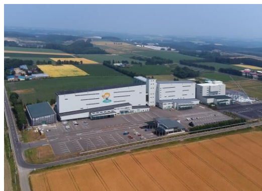
網走市 麦類乾燥調製貯蔵施設
