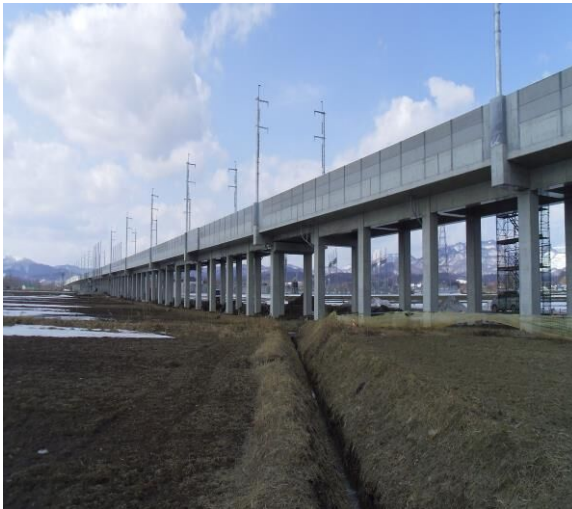
■ 函館新幹線工事の写真
