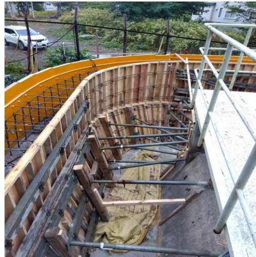
■ 型枠施工状況の一例
