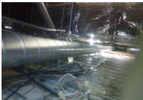
■換気工事の現場
