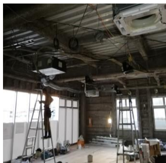
■空調工事の様子
