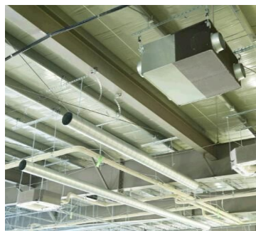
■ダクト工事施行例
