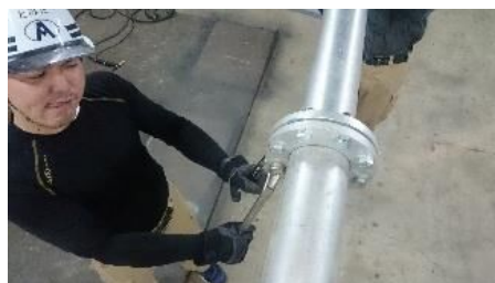
■配管施工の様子
