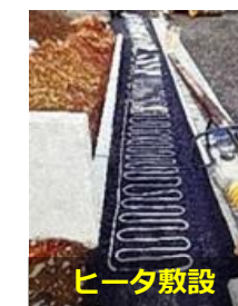
断熱材布設(スロープ)
