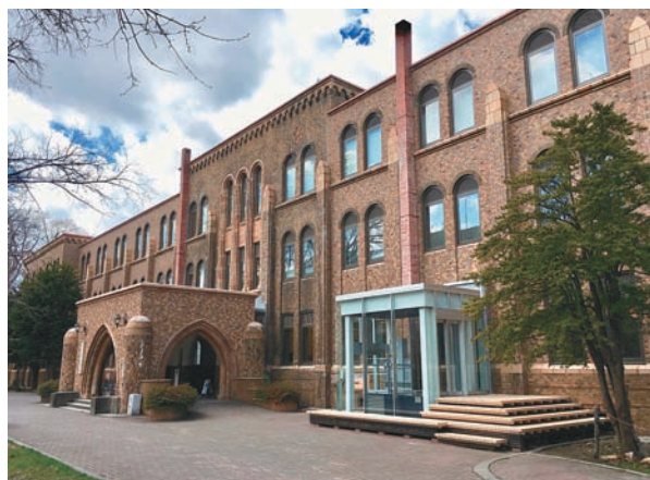
写真8：車いす利用者向け段差解消機とウッドデッキ
