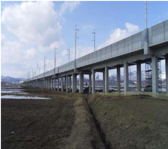
■ 函館新幹線工事の写真
