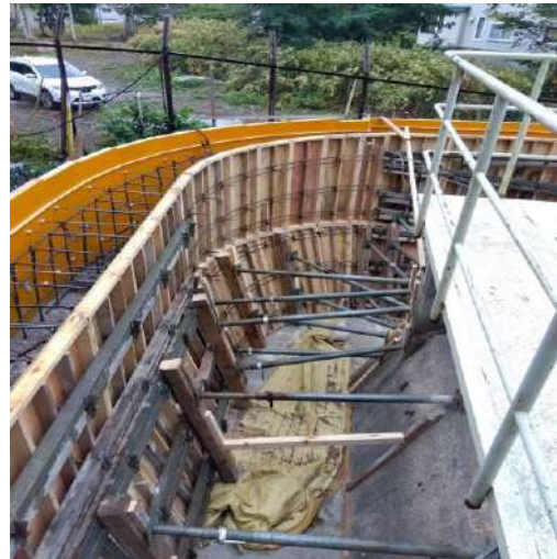
■ 型枠施工状況の一例
