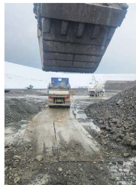
▲ 最終処分場建設エリアの造成工事の様子。掘削作業をしつつ、発生した山ずり(岩石や土砂)を運搬している。
