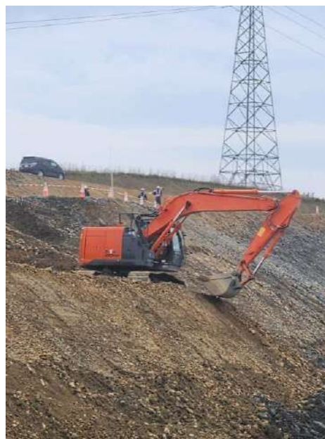
▲ 最終処分場建設エリアの造成工事の様子。掘削作業をしつつ、発生した山ずり(岩石や土砂)を運搬している。
