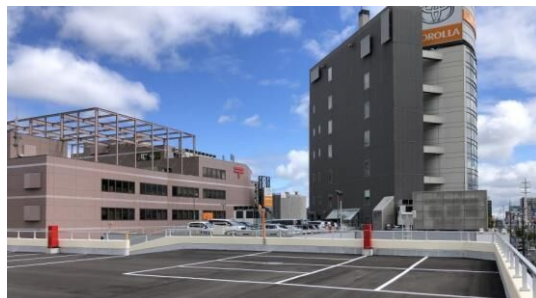
▲トヨタカローラ札幌(株)本店第1工場・ 駐車場新築・第2工場増築工事
