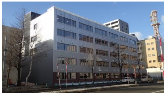
▲中央小学校校舎棟改築ほか衛生設備工事
