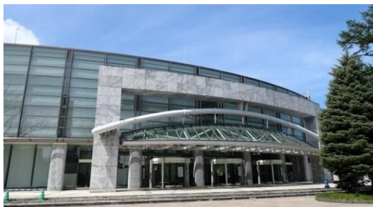
▲札幌コンサートホール改修冷暖房衛生設備工事
