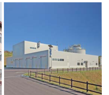
稚内市バイオエネルギーセンター
