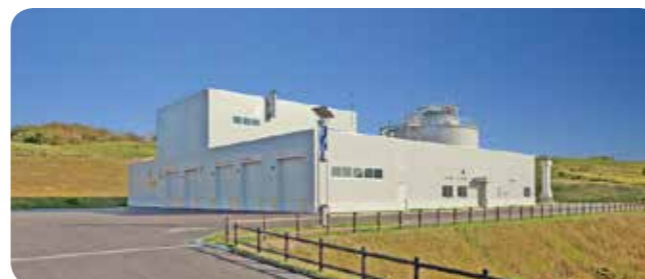
稚内市バイオエネルギーセンター
