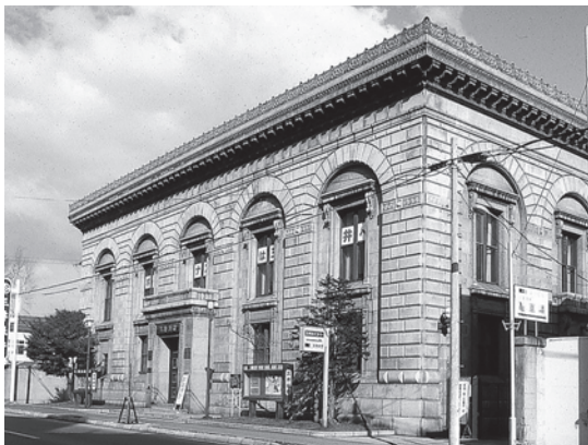
写真4 旧三井銀行小樽支店本館
