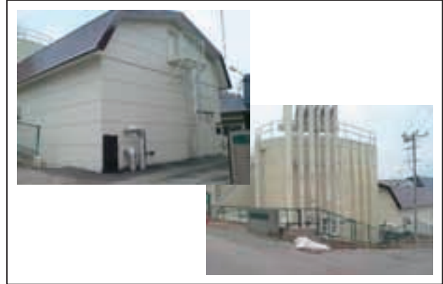
図表12 洞爺湖温泉のヒートポンプ室と貯湯槽
