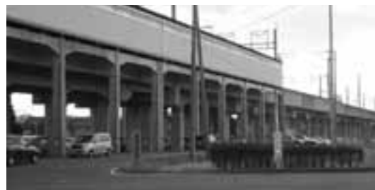
図表18 くりこま高原駅の高架下付近に広がる無料駐車場
