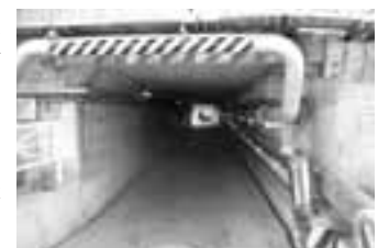
図表９ 米原市街の東西を結ぶ地下通路
