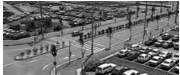
図表11 米原駅東西自由通路・橋上駅舎整備事業(資料：米原市)
