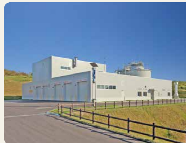
稚内市バイオエネルギーセンター
