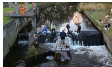
〈平成26年9月実施の「手づくり魚道」の補修作業〉
